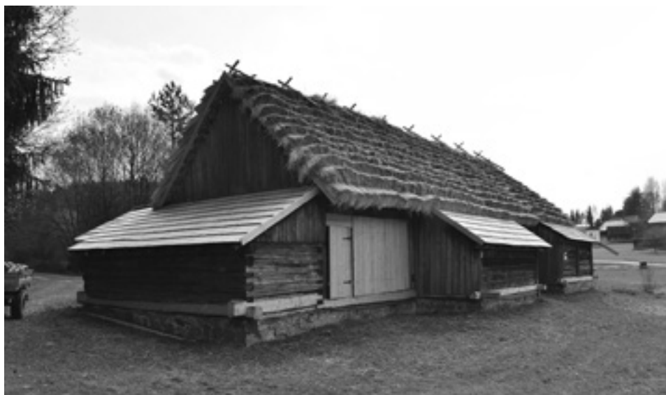
Obr. 1. Usadlosť z Kaľamenovej v Múzeu slovenskej dediny, hospodárska časť po II. etape rekonštrukčných prác. Foto J. Neplech, 2019
