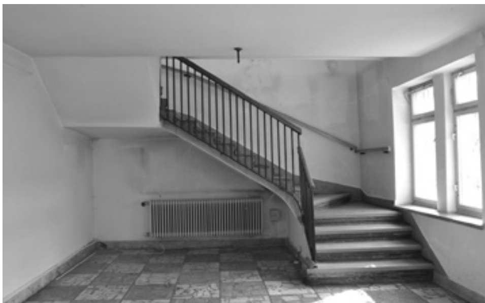
Obr. 2, 3. Vyst'ahované priestory Múzea Martina Benku pred začiatkom rekonštrukčných prác. Pohľad zo vstupného priestoru na schodisko a do ateliéru. Foto M. Kiripolská, 2019 Fig. 2, 3. Emptied premises of the Martin Benka Museum before the beginning of the renovation work. View from the entrance towards the staircase and the studio. Photograph by M. Kiripolská, 2019
