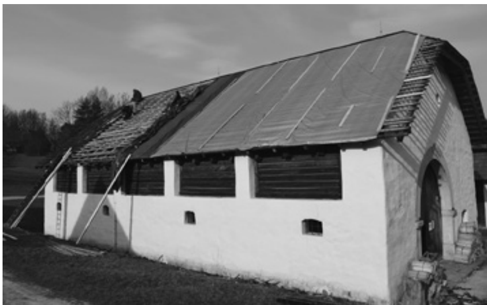
Obr. 1. Kladenie šindľovej strešnej krytiny na voziarni z Moškovca. Foto J. Neplech, 2019 Fig. 1. Placing shingle roofing on the cart-house from Moškovec. Photograph by J. Neplech, 2019
