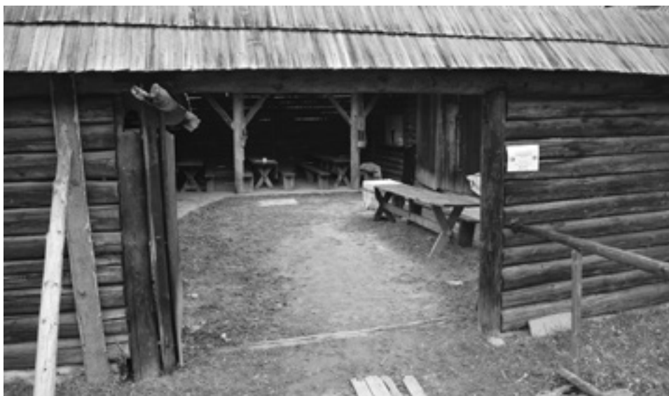
Obr. 6, 7. Átrium hospodárskej časti krčmy z Oravskej Polhory pred a po jeho odvodnení a spevnení. Foto J. Neplech, 2019
