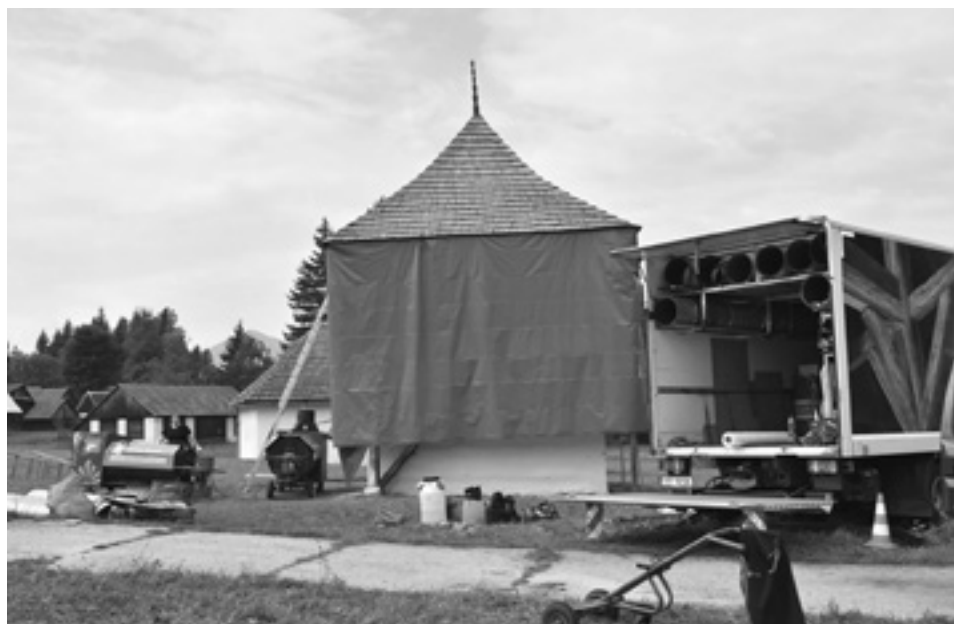
Obr. 8. Teplovzdušná sanácia filagórie zo Slovenského Pravna. Foto S. Jaššová, 2019 Fig. 8. Hot air decontamination of the folly from Slovenské Pravno. Photograph by S. Jaššová, 2019
